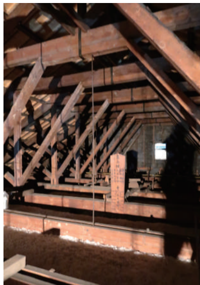
小屋組の様子
